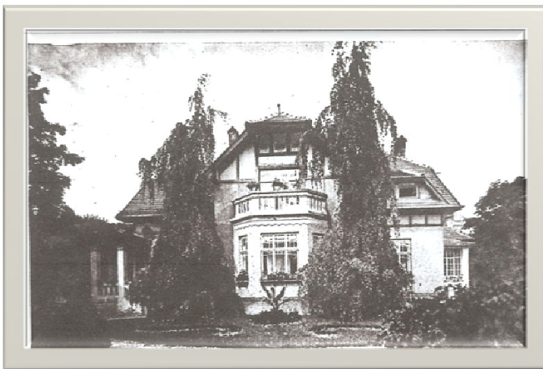
Budynek 'Dyrektorówki' na fotografii z okresu międzywojennego
